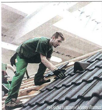
Pokládka betonové krytiny Bramac
