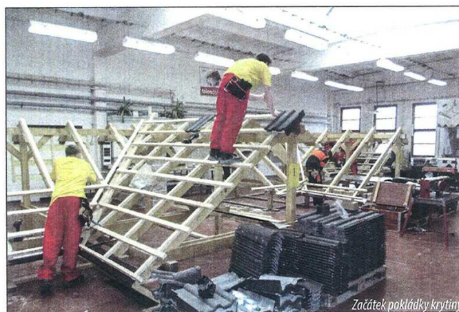
Začátek pokládky krytiny
